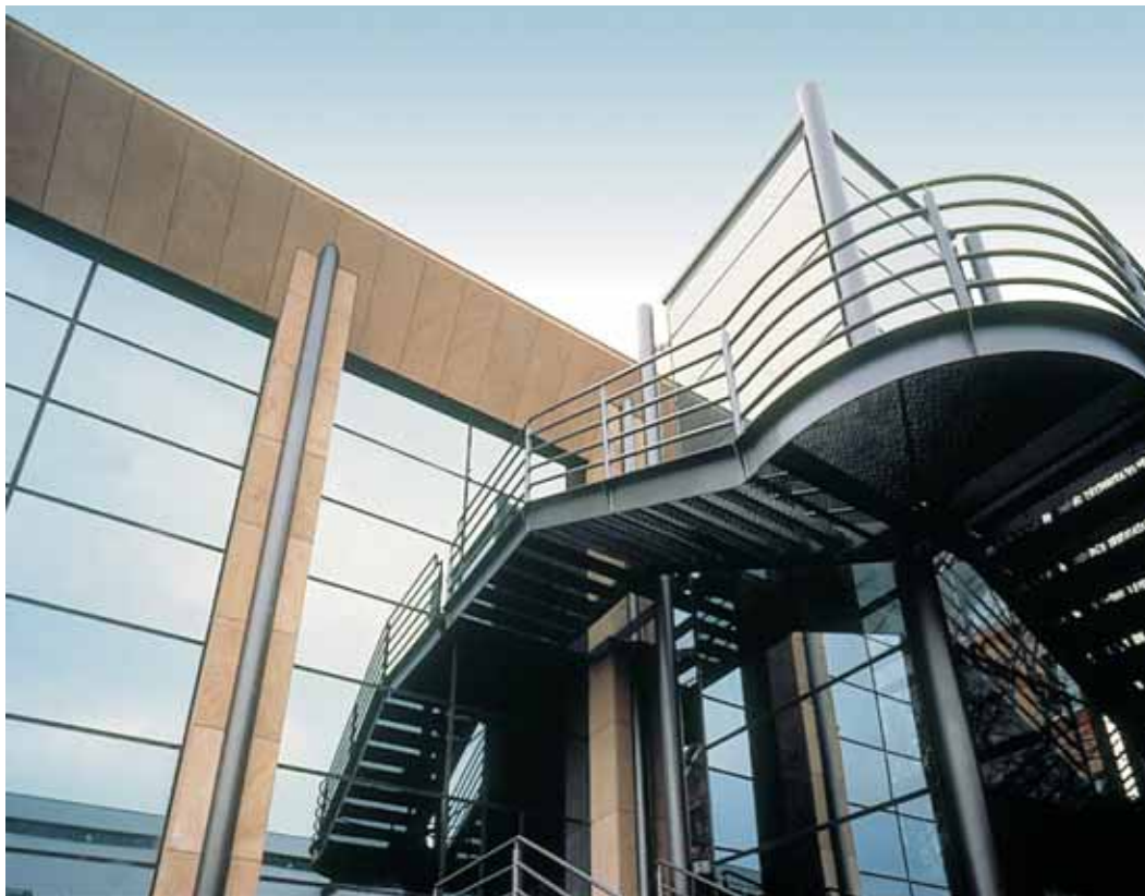
Struttura metallica scala uscita di emergenza
