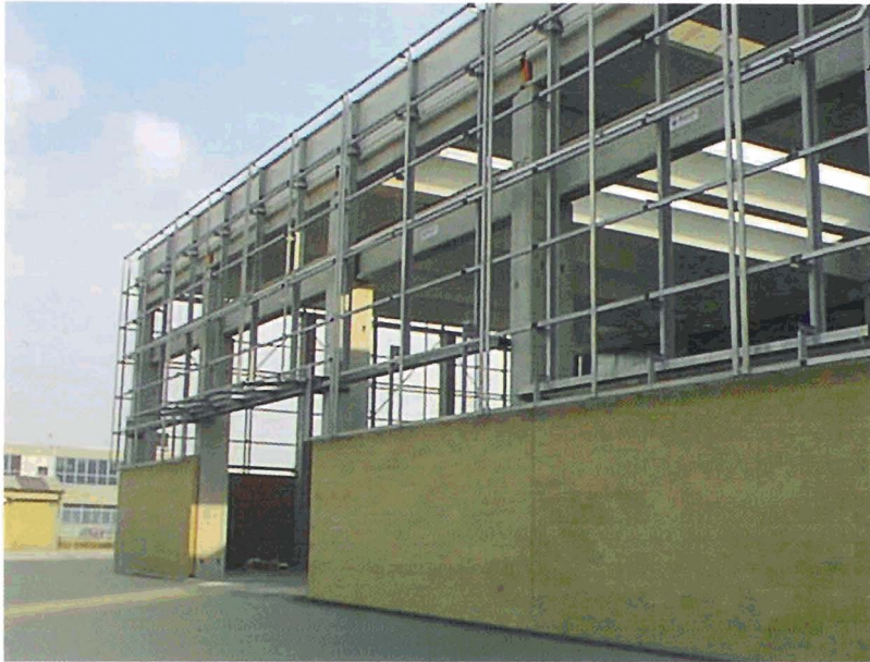
Scorcio di struttura capannone industriale
