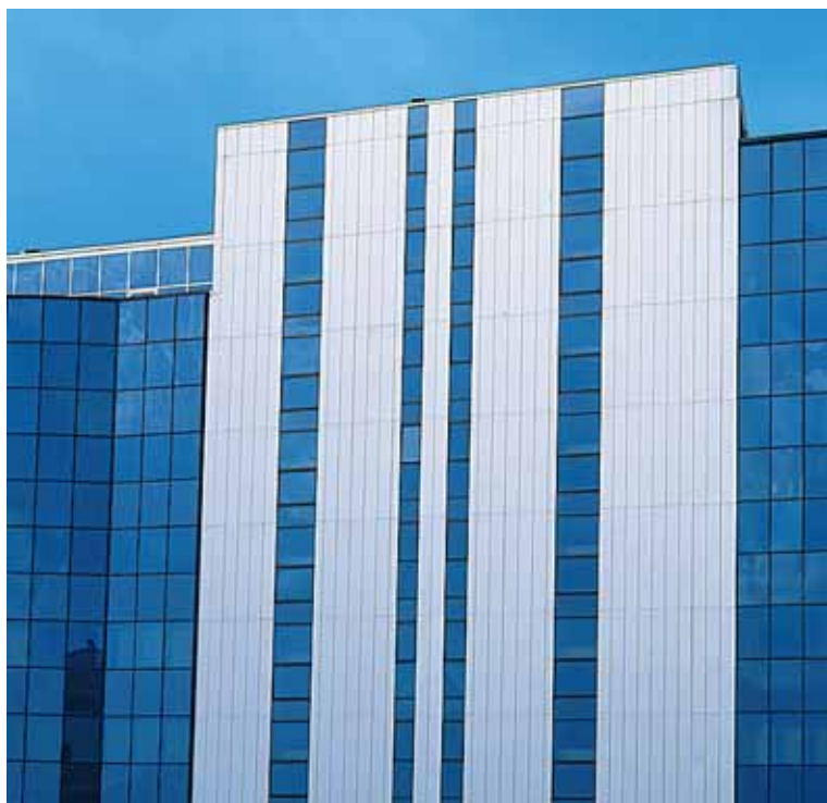
Particolare di facciata : raccordo tra i piani con pannelli, in alluminio sp. 30/10 calandrati
