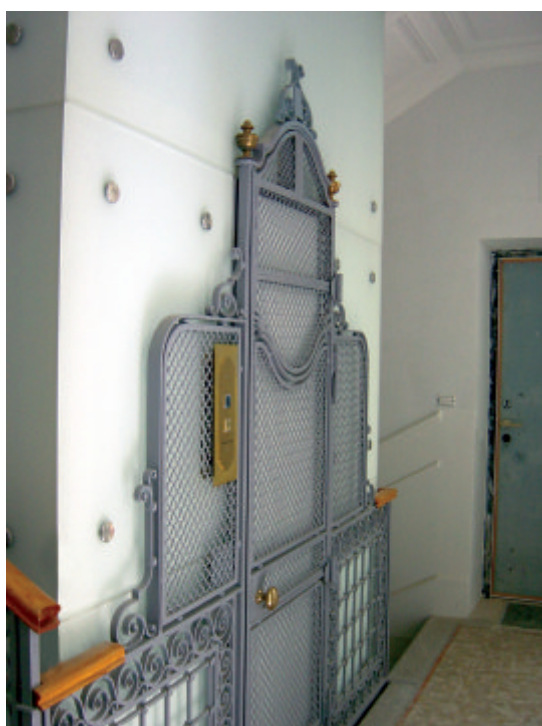
Fornitura e posa in opera di lastre in cristallo a formazione rivestimento della struttura vano ascensore esistente in carpenteria metallica.
