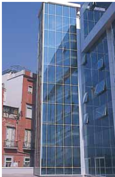
Particolare facciata vano scale realizzata con sistema "Montanti e Traversi" a Taglio Termico sezioni in vista mm 50
